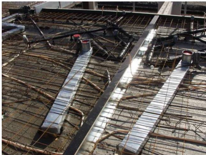
Figuur 2.1. Voorbeeld van het horizontale installatiewerk.
